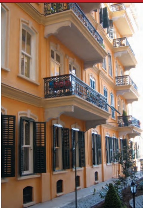
写真-10 新装されたガラタ地区の集合住宅
