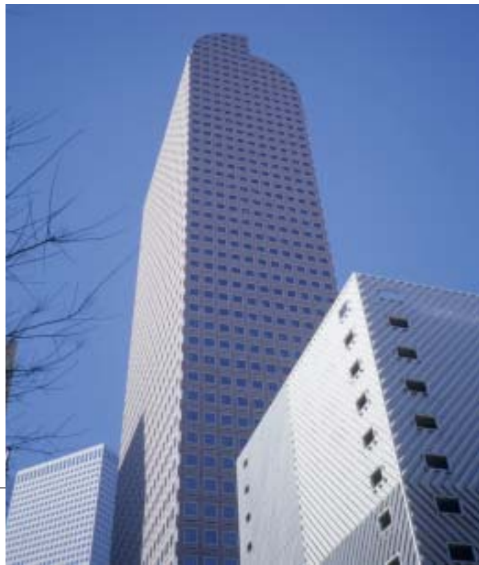
写真-7 ノース・ウエスト・タワー
